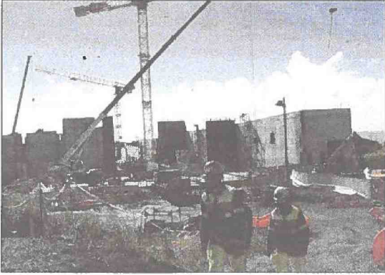
Les travaux ont bien avancé au futur centre de traitement des déchets, même si une suspension du marché a été prononcée par le Conseil d'État en attendant un examen sur le fond. (Photo Philippe Chan Cheung)
